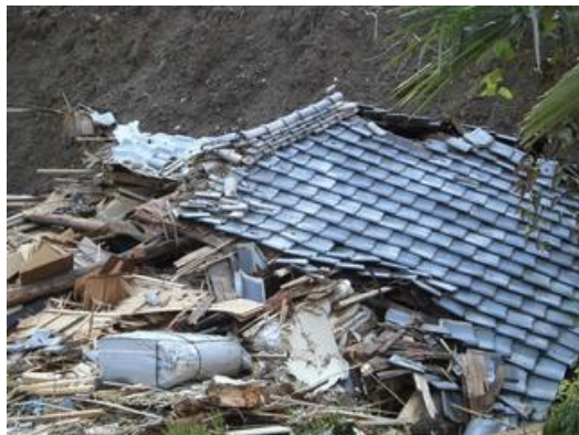
土砂に埋もれ屋根だけの家屋
