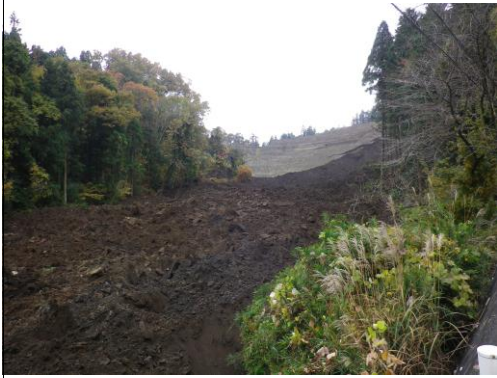
崩落現場の全体像
