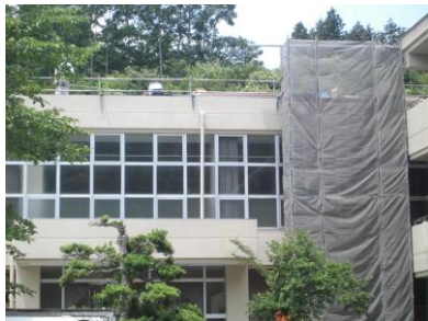
三沢小改修工事
