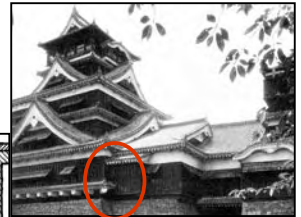
熊本城の空中厠 竹の床である。 多分換気は最良であろう。
