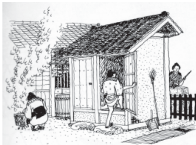
京都, 大阪地方の共有便所 惣雪隠 江戸の惣後架に比べはるかに整って造られている。
