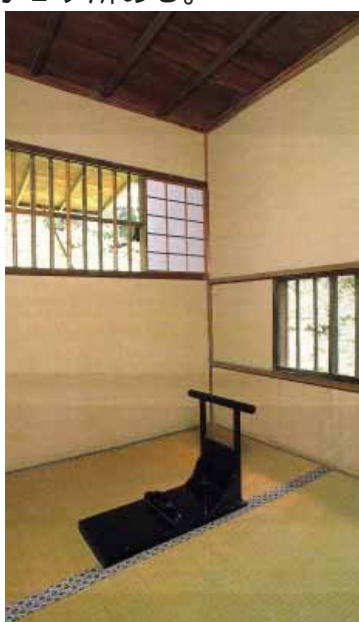
右、臨春閣、座敷床の間裏の廁 紋縁付畳が敷かれ黒漆塗蓋付大便器の下には引出しがあり、砂雪隠となっている。
